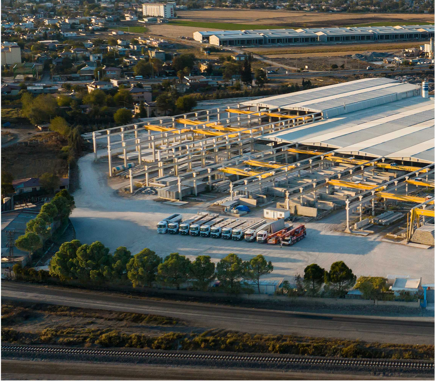
Beton Yapı Üretim Üssü
