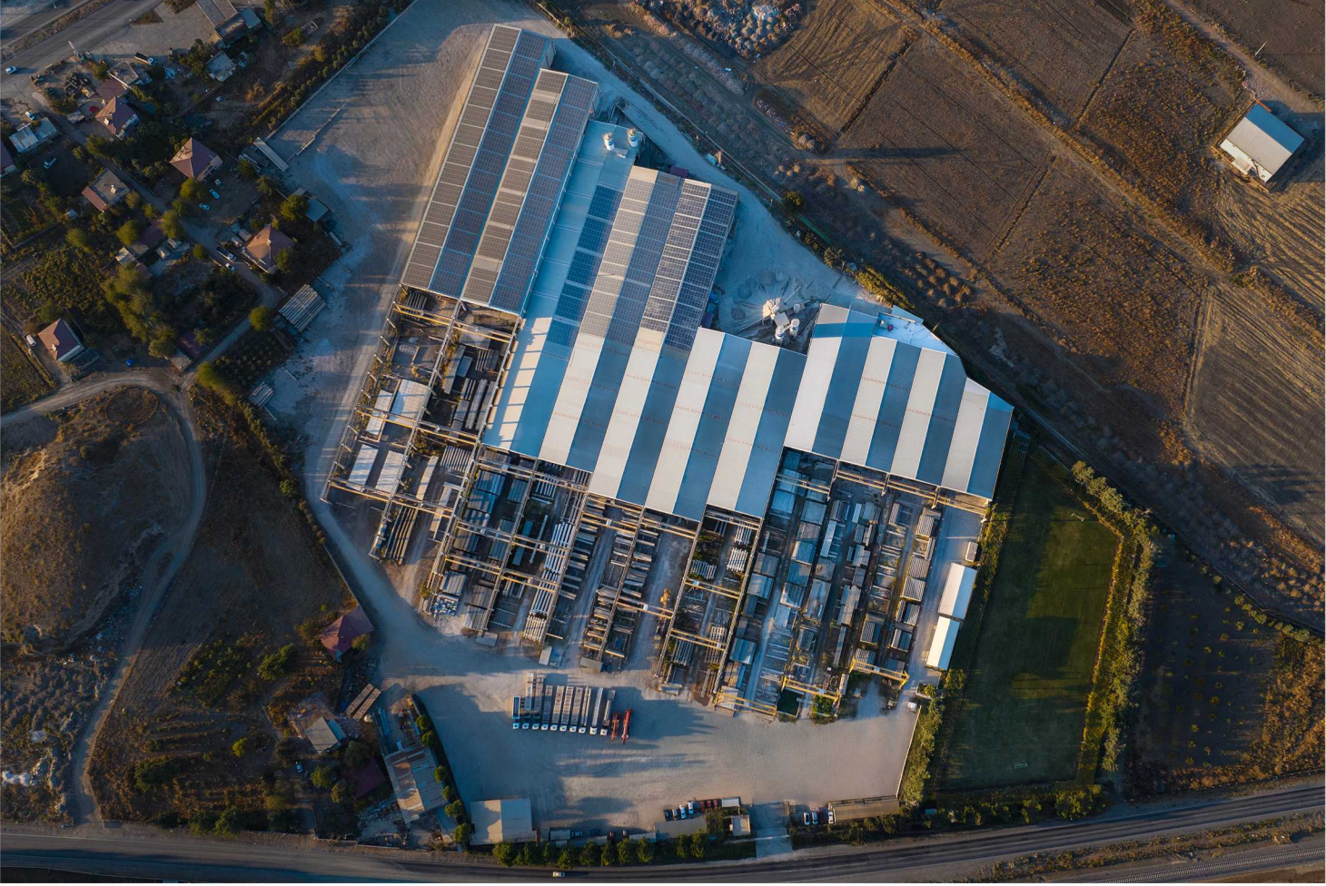
Beton Yapı Üretim Üssü
